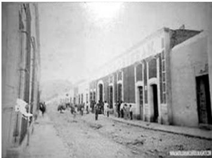
El mesón de San Esteban. En este espacio se encuentra actualmente el edificio que hasta hace pocos años albergó a las instalaciones del Hotel Arizpe-Sáinz. Adviértase el pésimo estado de la calle. Las rejas de hierro aparecieron en las primeras décadas del siglo XIX. / Fotografía c.a. fines del S.XIX/saltillodelrecuerdoblogspot.com
